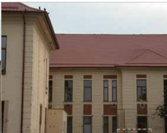
ZŠ P.Pázmány - výmena strechy a okien
