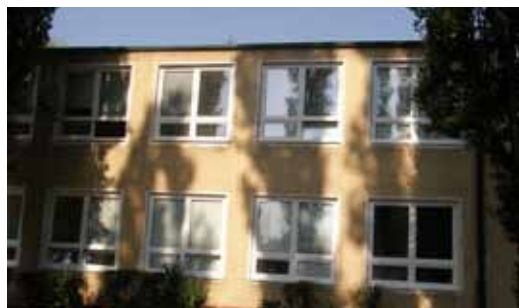
MŠ Budovateľská - výmena okien
