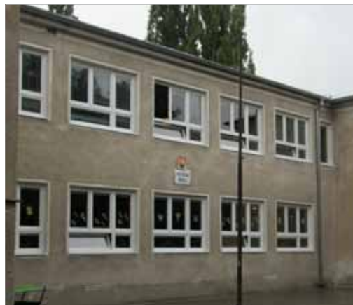
ZŠ L. Štúra - výmena okien
