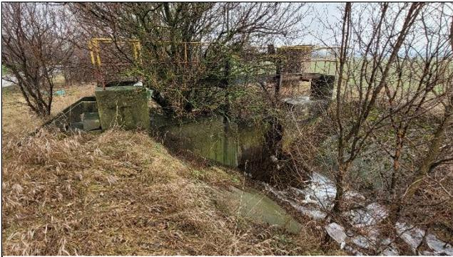
Stavidlo na Hetméňskem kanále – treba opraviť a vyčistiť kanál od náletov drevín do výšky očakávanej maximálnej hladiny vody.
