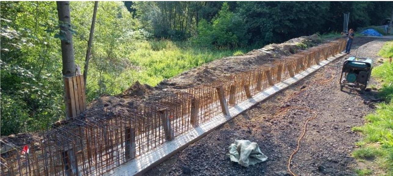
Obr. 91: Spevnenie brehu toku rieky Olše (Třinec, ČR)
