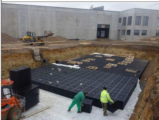
Odvodnenie systémom vsakovacích blokov
