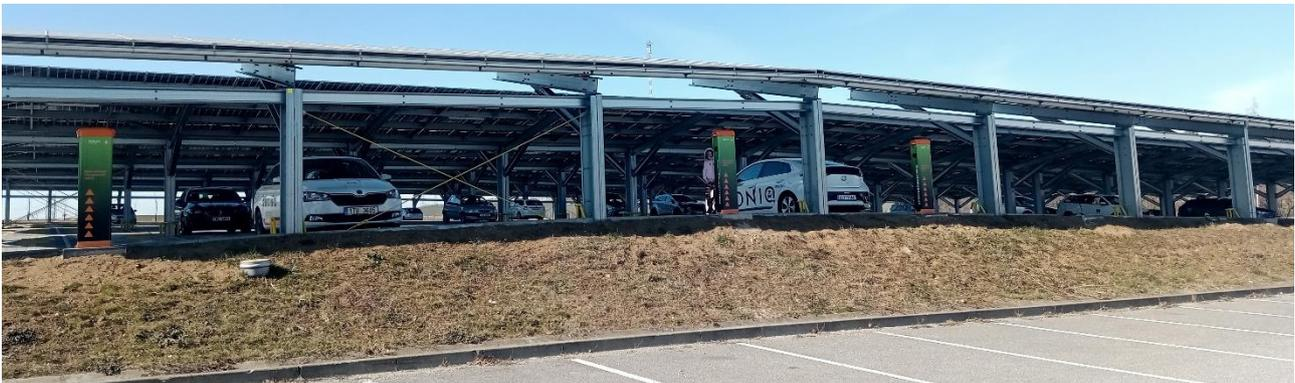
*Obr. 87: Parkovisko Carport Dukovany (ČR), zastrešenie so solárnymi kolektory, priame nabíjanie vozidiel na elektro pohon.*
