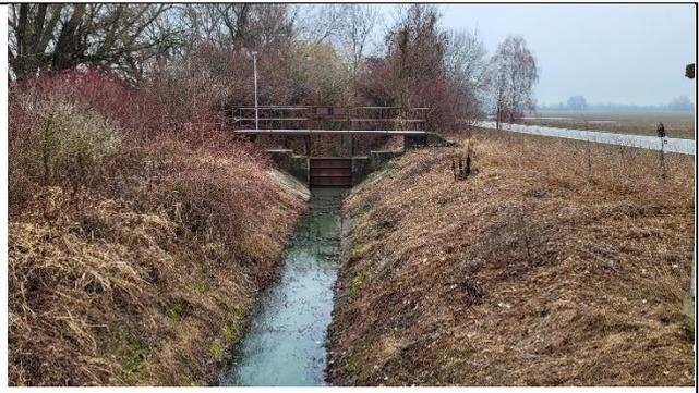
Stavidlo na Selickém kanále – opravené, treba vyčistiť kanál od náletov drevín za stavidlom do výšky očakávanej maximálnej hladiny vody.
