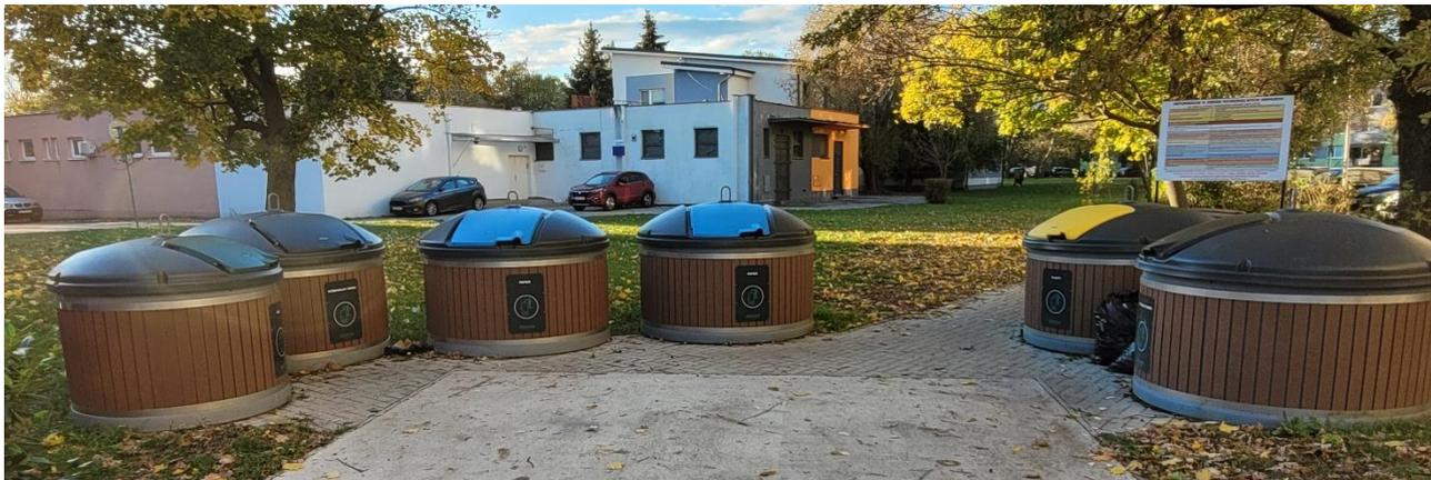
*Obr. 29: Polopodzemné kontejnery na separovaný odpad*
