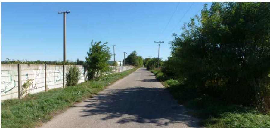
obr. 4: prístupová cesta do územia Šalianskej tabule – úseky na Družstevnej ulici pre lokalitu navrhovaného miestneho centra Vršky
